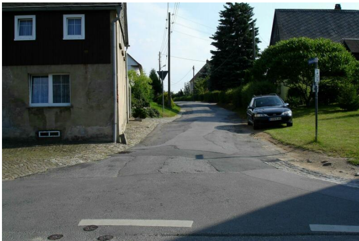
Zustand vor dem Ausbau
