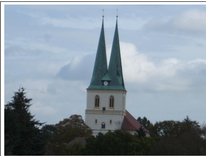
Turm nach der Teil-Fertigstellung
