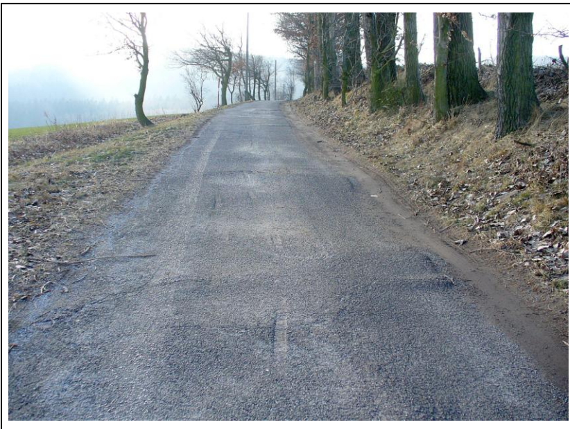
Ausgangssituation bei Baubeginn
